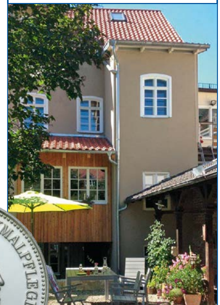
Fassade vor der Sanierung
